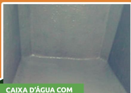
CAIXA D'ÁGUA COM IMPERMEABILIZAÇÃO
